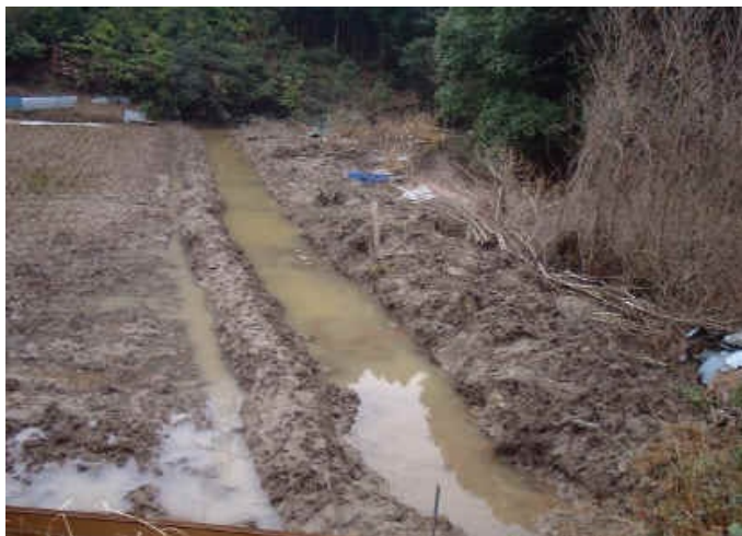
(完成！！畦を造ったというよりも、水路を造った。
