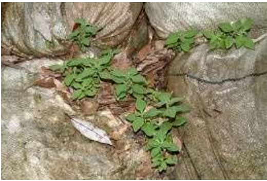
土囊の隙間にも生育
