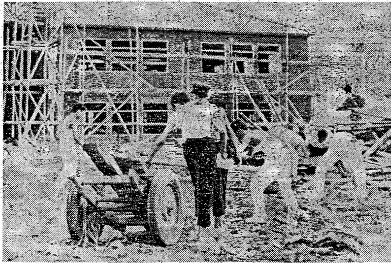
「自分たちの校舎を」と熱心に作業する中学生たち(1962年8月、大津市木下町の学校建設現場で—滋賀朝鮮初中級学校提供)
