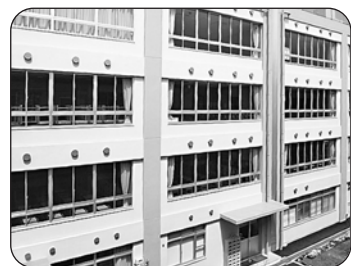
学校校舎の耐震補強
