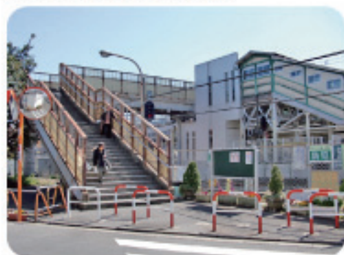
JR南武線「宿河原駅」の跨線橋
