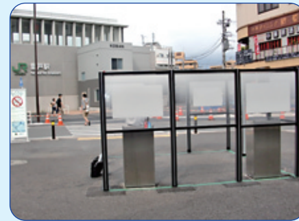
▲完成した登戸駅前広場の喫煙場
