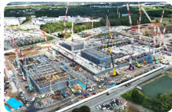
急ピッチで建設が進むTSMC
